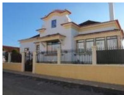
Figura 5 – Edifício em excelente estado de conservação, com características arquitetónicas relevantes
