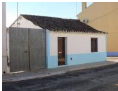
Figura 2 – Edifício popular de características tipicamente rurais.
