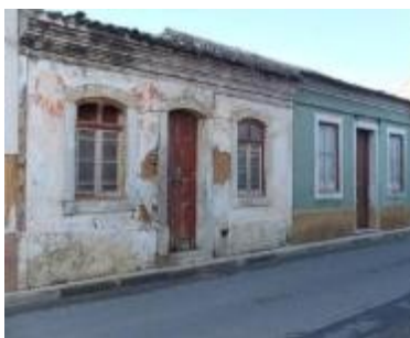
Figura 8 – Edifício em ruína. Apenas com fachada preservada
