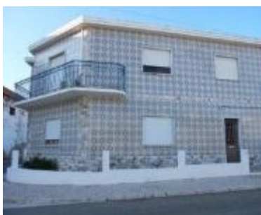
Figura 11 – Edifício com utilização de revestimentos dissonantes.
