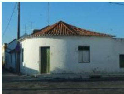
Figura 1 – Edifício popular de características tipicamente rurais.
