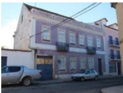
Figura 3 – Edifício com características arquitetónicas relevantes sem alterações significativas na fachada.
